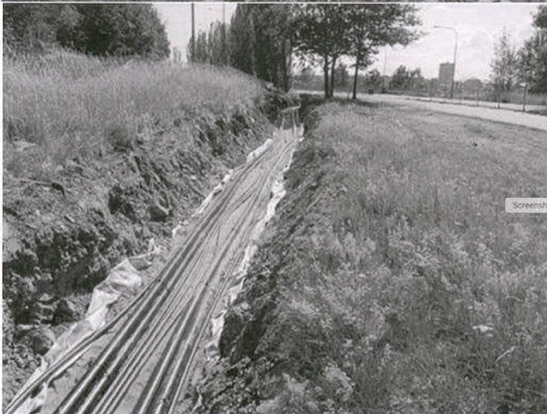
Mynd 7. 220 kV strenglögn með vegi í Stokkhólmi, eftir og fyrir frágang
